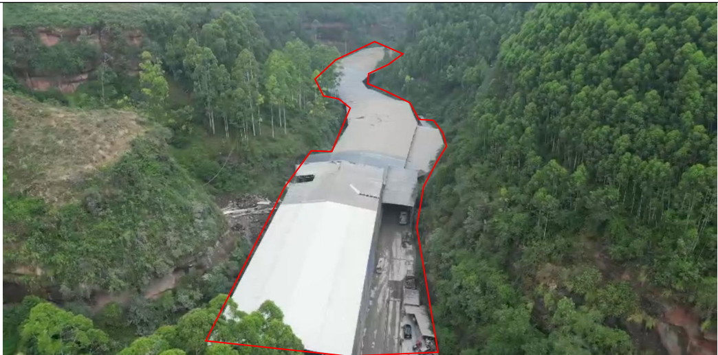
图 2-3 项目厂界周边现场图
