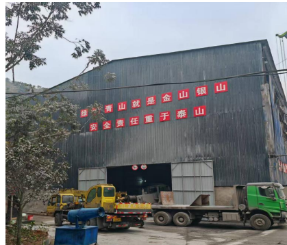
生产厂房封闭情况
